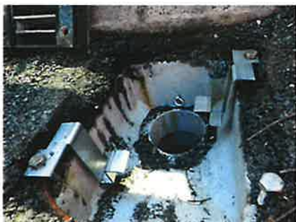
グレーチングホルダー用 アングル取付（受枠取り外し）
